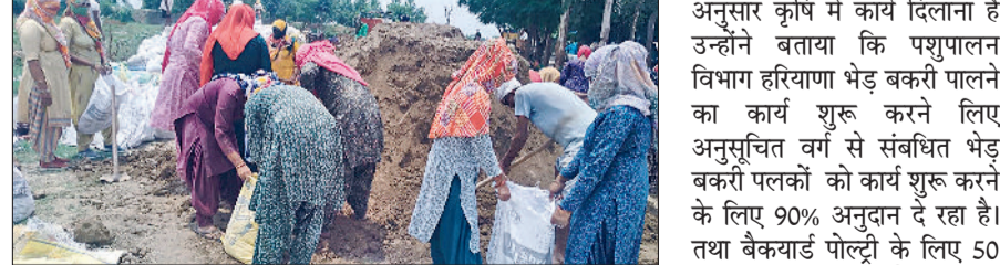
घरौडा। गांव लालपुरा में यमुना नदी बाढ़ नियंत्रण में लगे मनरेगा मजदूर।
